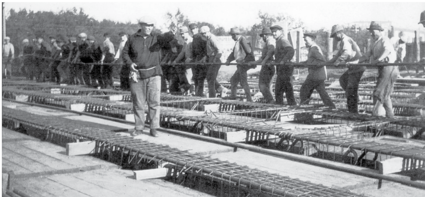
Строительство виадука в Харбине. 1904 год. Фото из архива Ионы Клизмана (Иерусалим)
