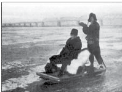
«Толкай-толкай» на фоне железнодорожного моста через Сунгари
